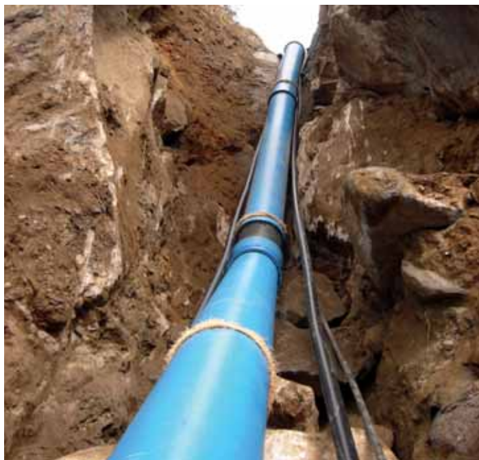
Pokládka trouby na skalnatém svahu
