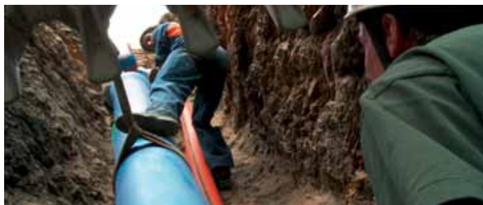
Pokládka na strmém svahu se sklonem až 85°
