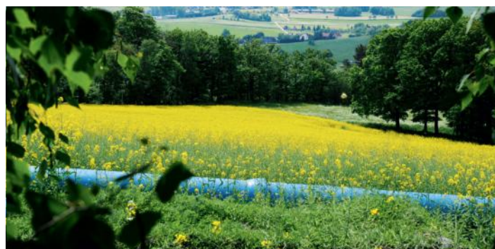
Dočasné (provizórne) potrubie so spojom BLS®
