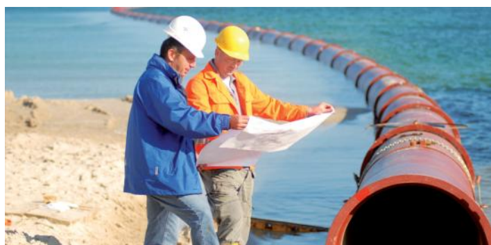
Vťahovanie potrubia z tvárnej liatiny so spojom BLS® v zatopenom kanáli
