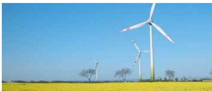
Větrný park Poysdorf-Wilfersdorf – Rakousko, 14 zařízení Vesta V90 – 28,0 MW
