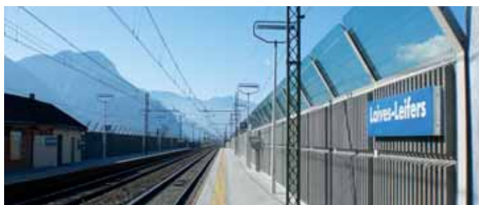
Protihluková ochrana Brennerachse – Itálie, 4,5 km železniční tratě
