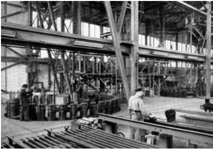
Otočné konstrukce s pískovými formami z období kolem roku 1900
